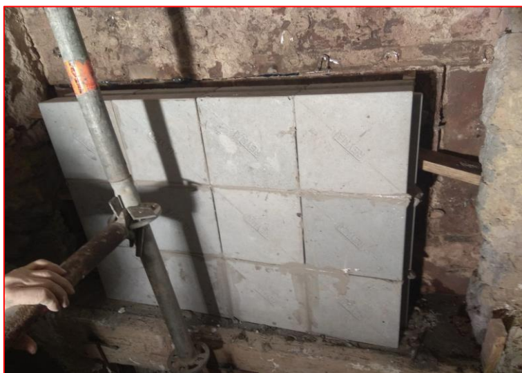
Paño de piezas instalado Ene20
